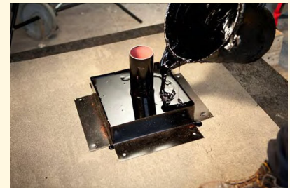
Pourable Sealant Example
