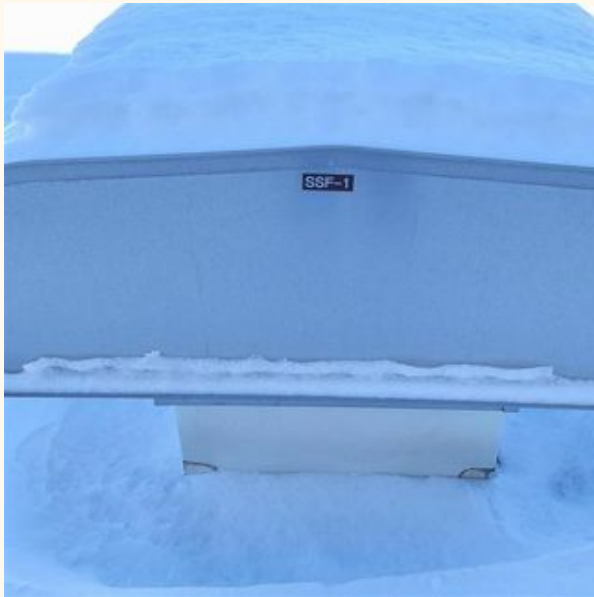
Stairwell Pressurization Fan
